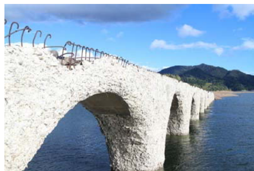
写真7 老朽化が進むタウシュベツ川橋梁
