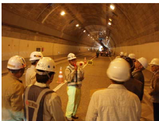
写真5 ぬかびら湖畔トンネル補修現場
