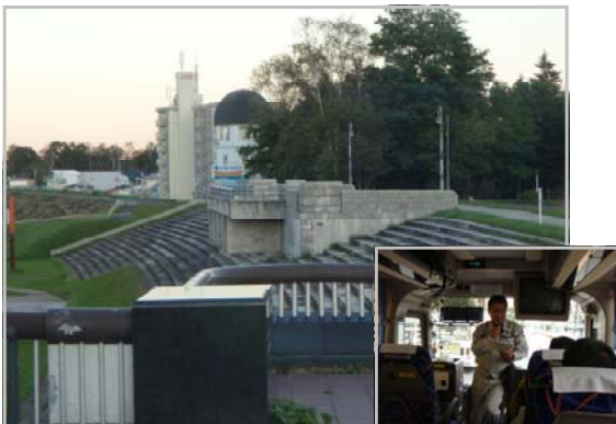
写真1 旧十勝大橋の橋台と説明状況
