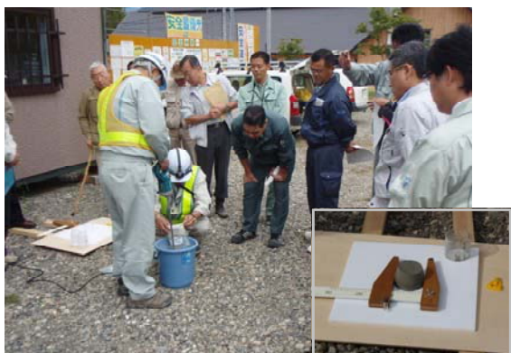
写真4 モルタル作成状況と品質管理状況
