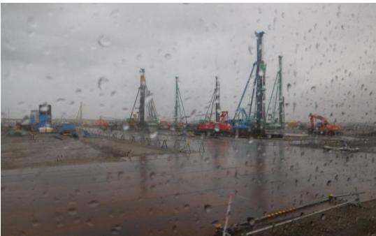
写真7 地盤改良機が林立している
