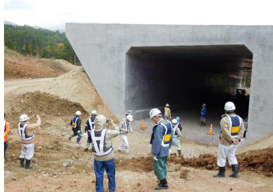
写真3 函渠(勾配10%以上)の見学
