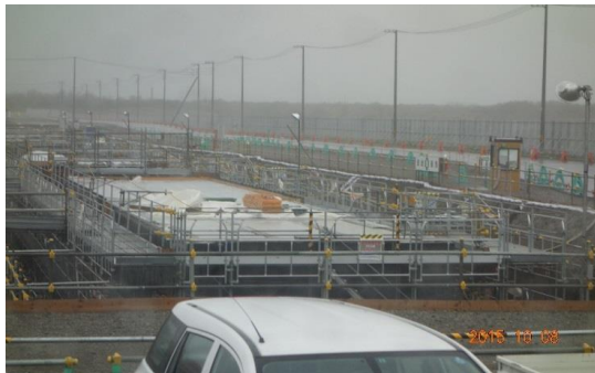
写真8 放水路蓋渠工事(斜め土留工による)
