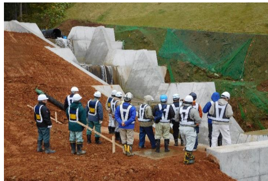
写真4 排水構造物(落差工)の見学
