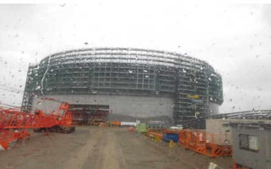
写真9 石狩LNG基地No.3貯槽
