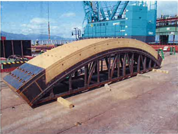
直接切削ブロック (シールド発進部)
