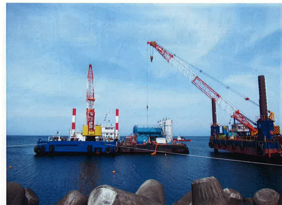
放水口 水中不分離性セメントミルク充填状況
