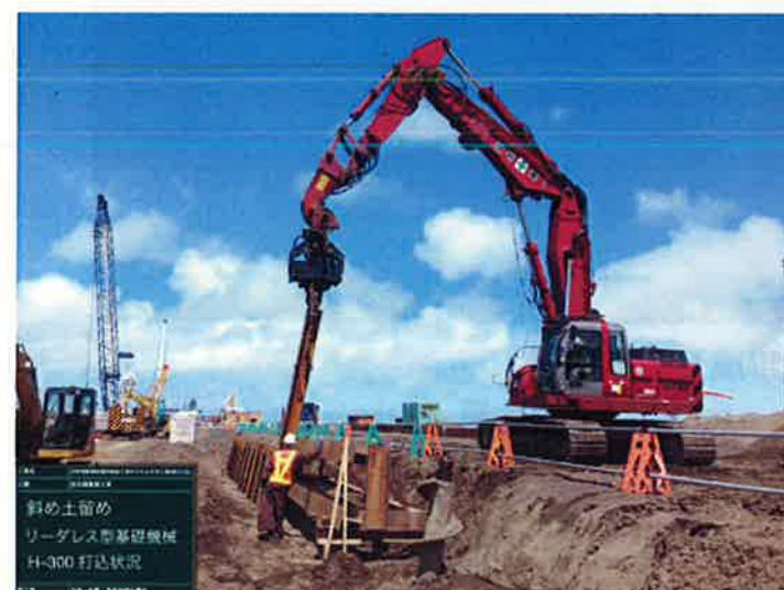
斜め土留工施工状況 (リーダレス型基礎機械タイプ)
