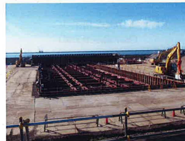
仮土留工・二次掘削状況
