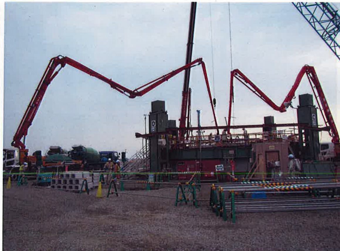
放水路立坑 水中コンクリート打設状況
