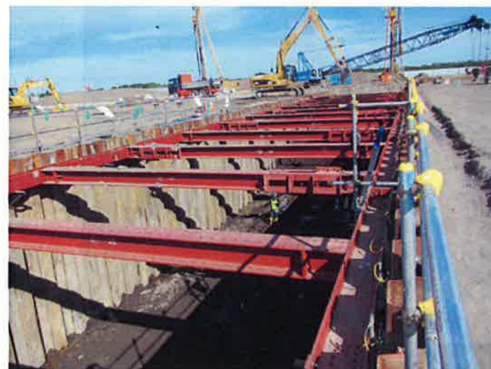
一般的な土留工 (ケーブルカルバート工事)
