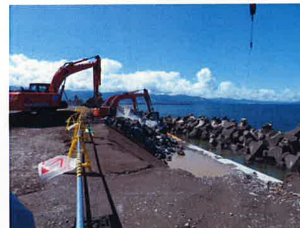
護岸撤去状況
