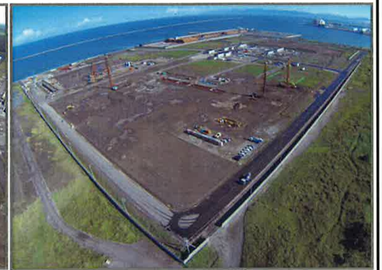
工事状況写真②
