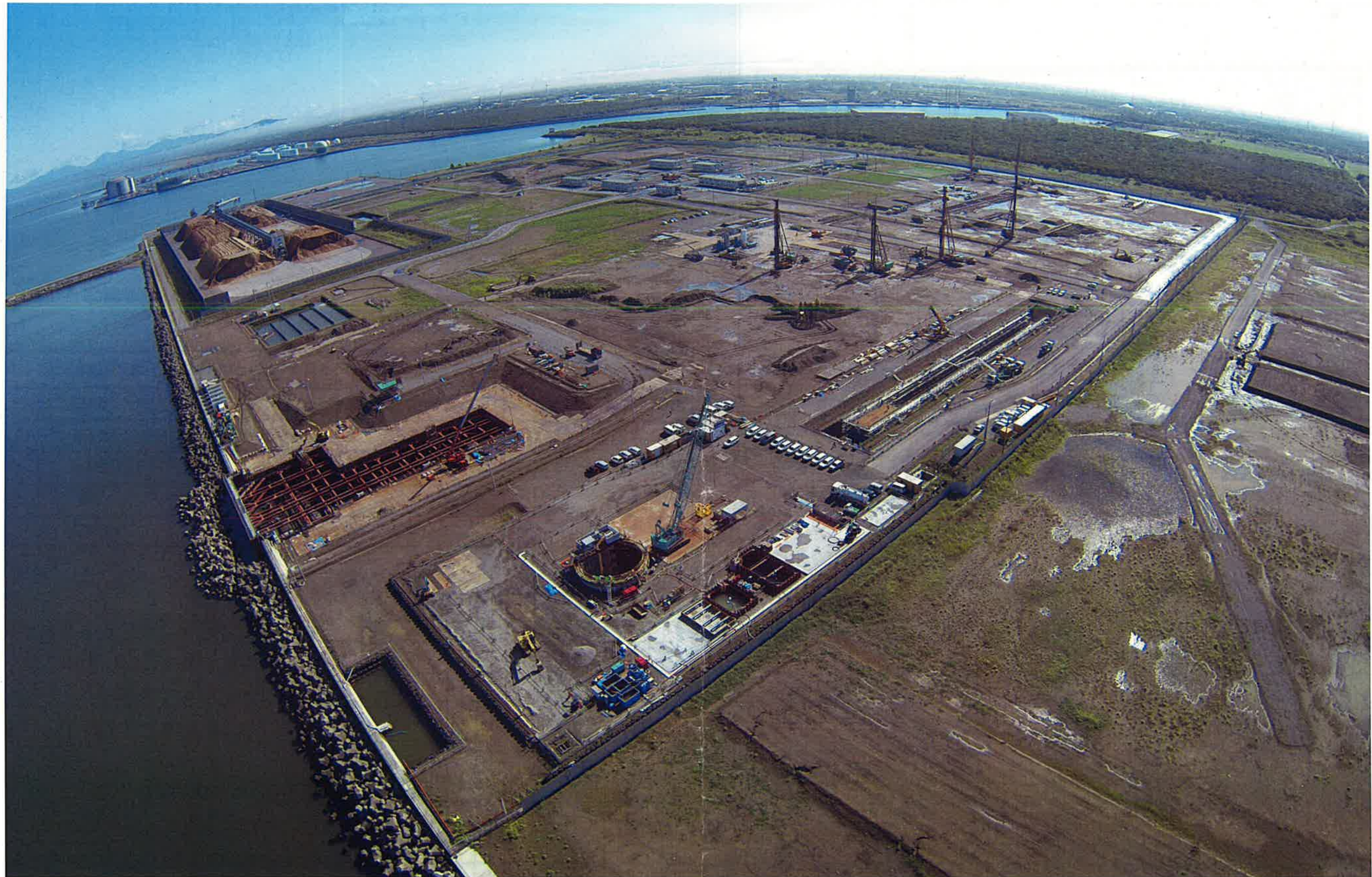
発電所工事エリア全景（平成27年9月14日撮影）
