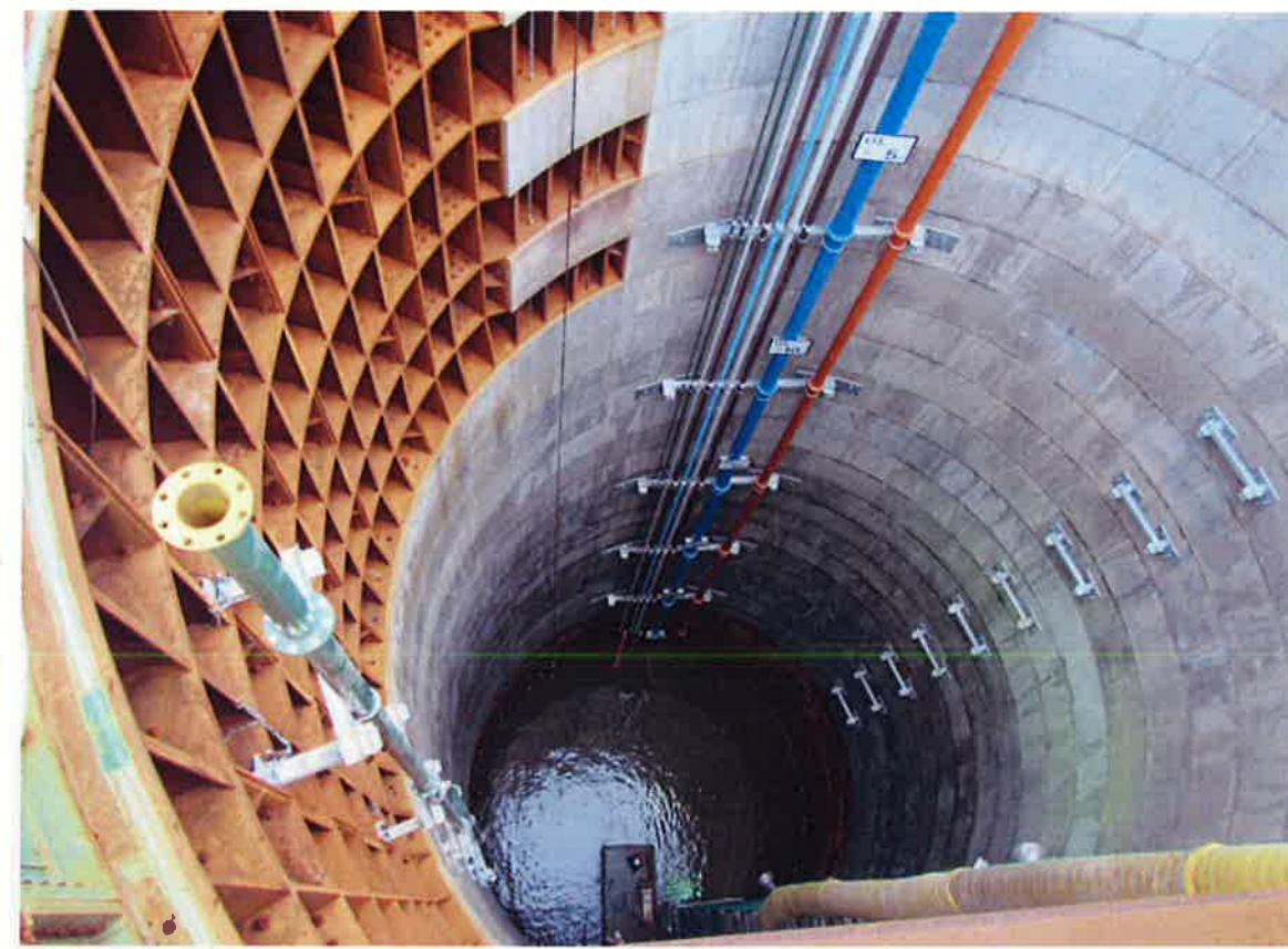
放水路立坑 坑内排水状況
