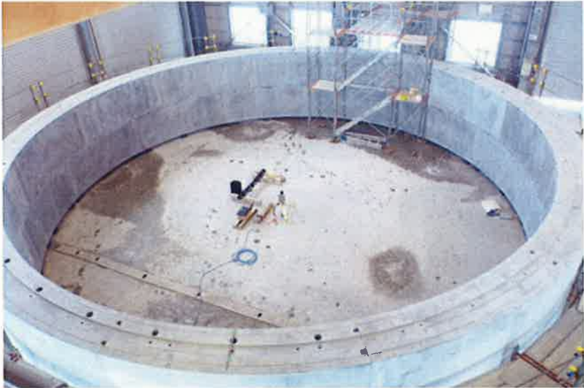
プレキャストブロック組立試験状況
