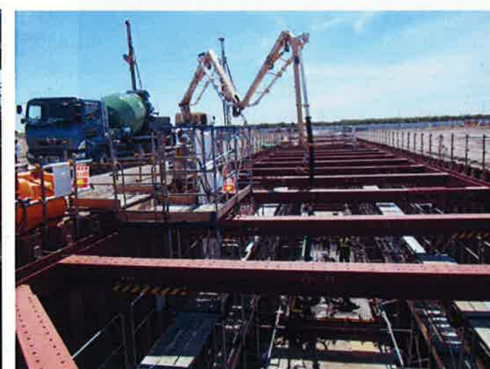
底版コンクリート打設状況
