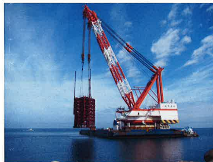
放水管設置状況
