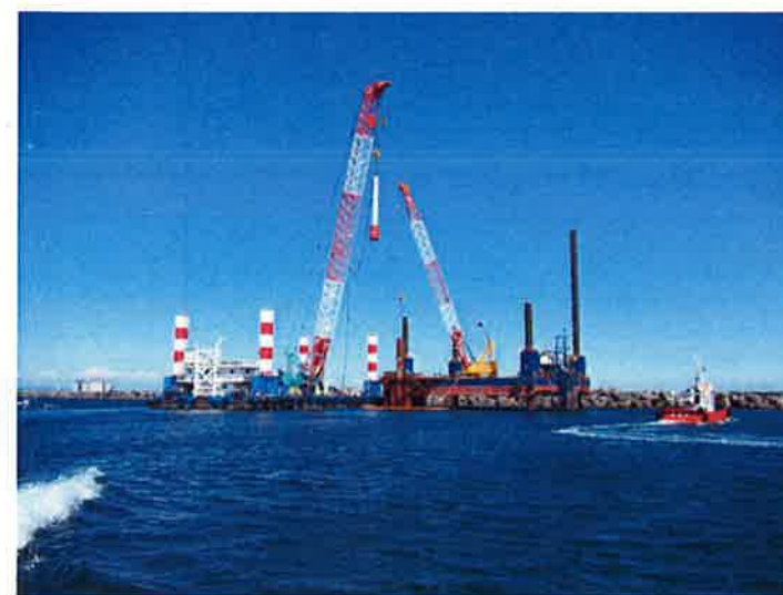
鋼管矢板打設状況
