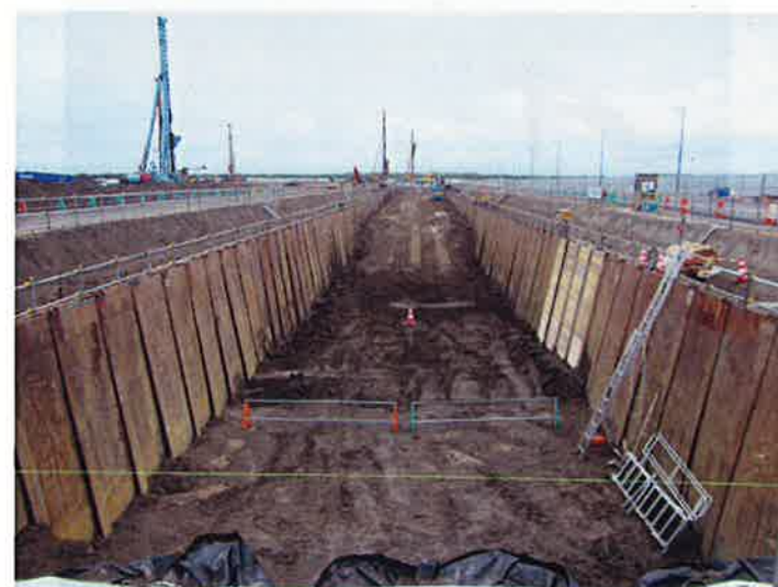
斜め土留工 (放水路蓋渠工事)
