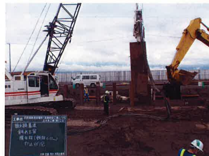
斜め土留工施工状況 (クローラークレーンタイプ)
