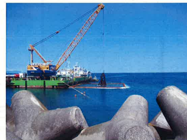
鋼管矢板井筒内浚渫状況
