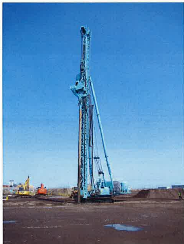
サンドコンパクション施工状況（左：動的，右：静的）
