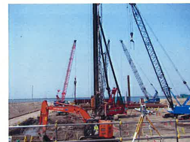
仮締切工・土留工・基礎杭工状況
