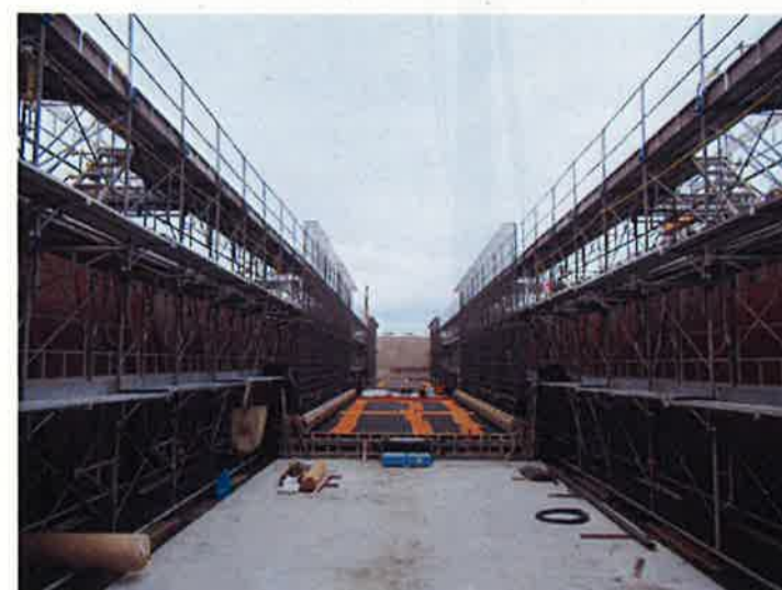
鉄筋組立状況
