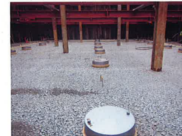
FT キャップ設置状況
