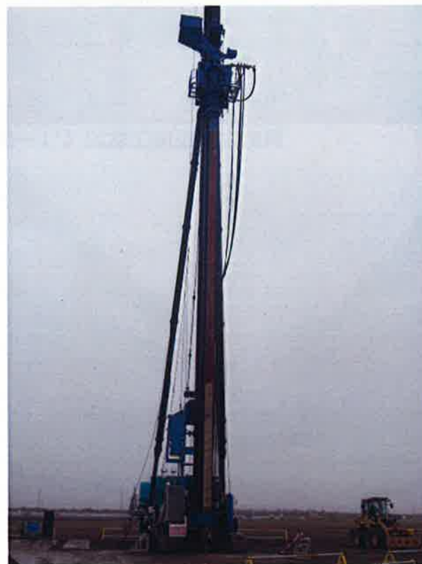
サンドコンパクション施工状況（左：動的，右：静的）
