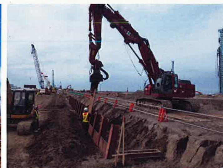
斜め土留工施工状況 (リーダレス型基礎機械タイプ)
