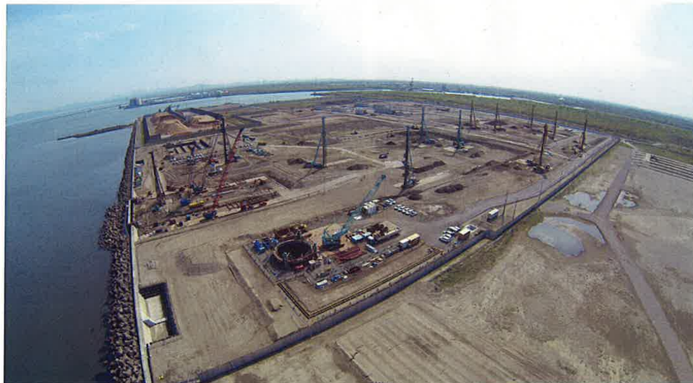
地盤改良工事最盛期状況（平成 27 年 5 月）
