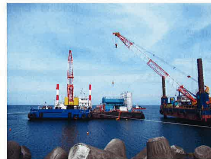
鋼管矢板井筒内セメントミルク打設状況
