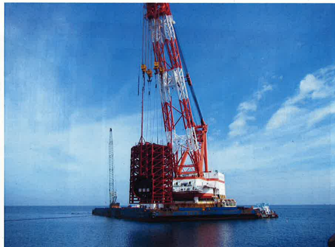
放水口 放水管設置状況
