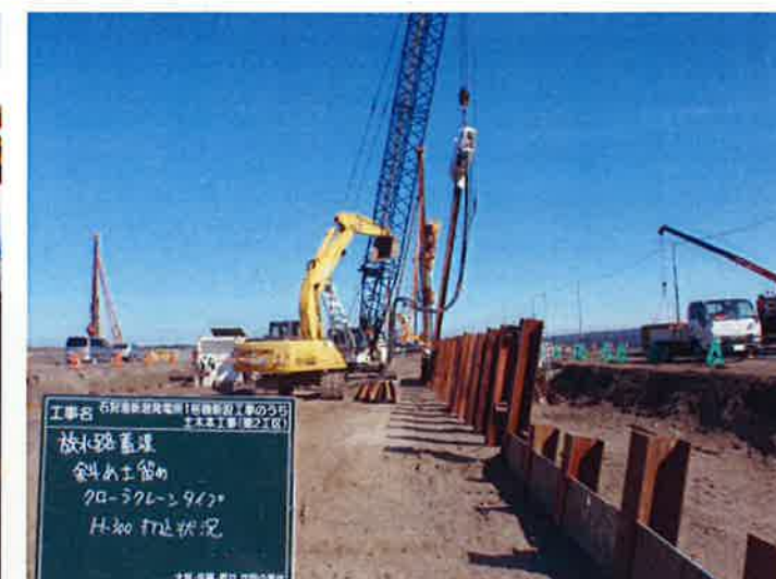
斜め土留工施工状況 (クローラークレーンタイプ)
