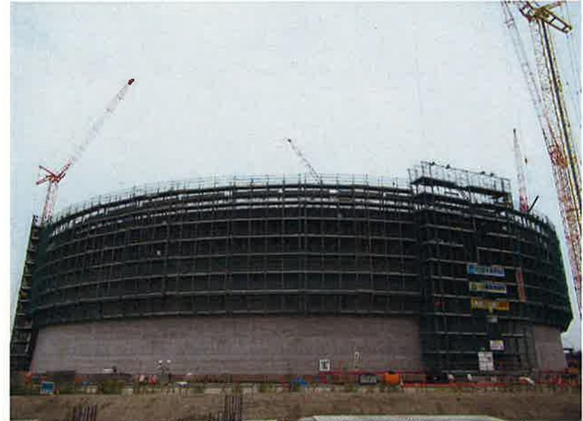
#5ロット 足場・鉄筋・型枠設置状況(内型枠スライド中)
