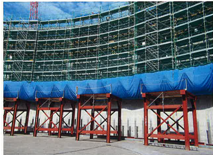
機械工事 貯槽内外周ベント設置状況
