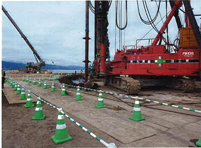
フレアスタック 支持杭打設状況
