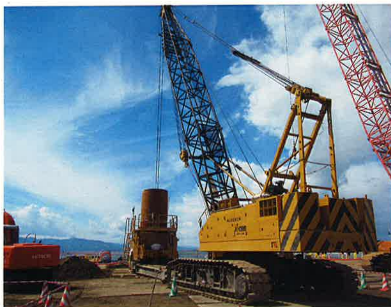
取水口・放水口 全周回転オールケーシング（砂置換工）
