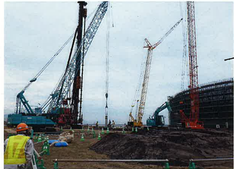
SMV気化器基礎 支持杭打設状況
