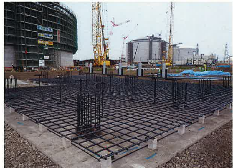
SMV気化器基礎 底版配筋状況（下筋）
