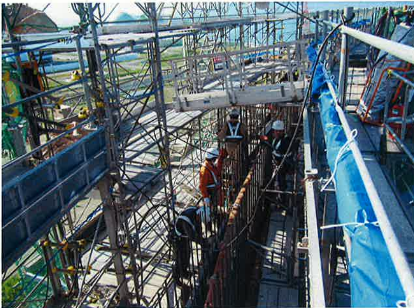
#5ロット コンクリート打設状況
