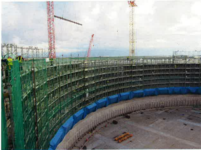
#5ロット 内型枠スライド状況
