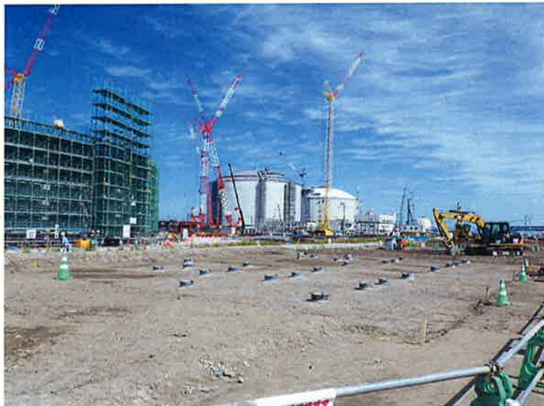
SMV気化器基礎 掘削・床付け完了
