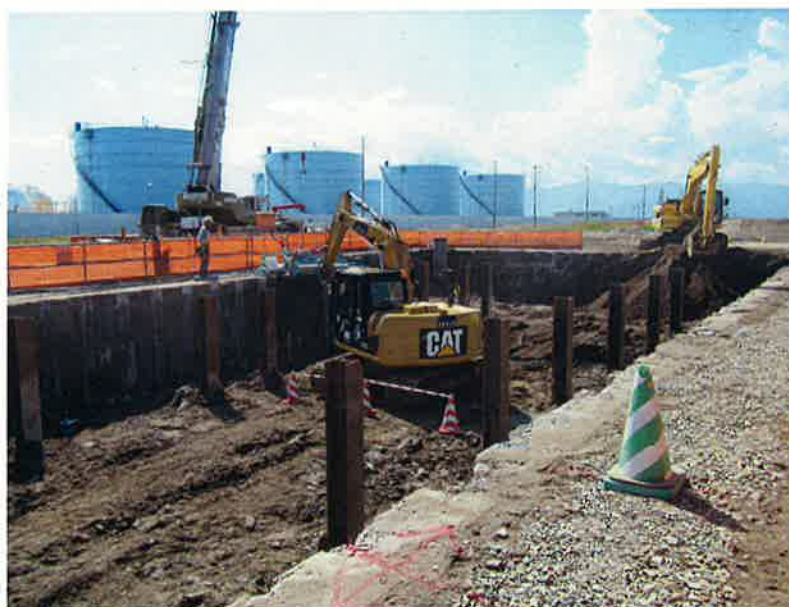
ポンプ室（掘削）
