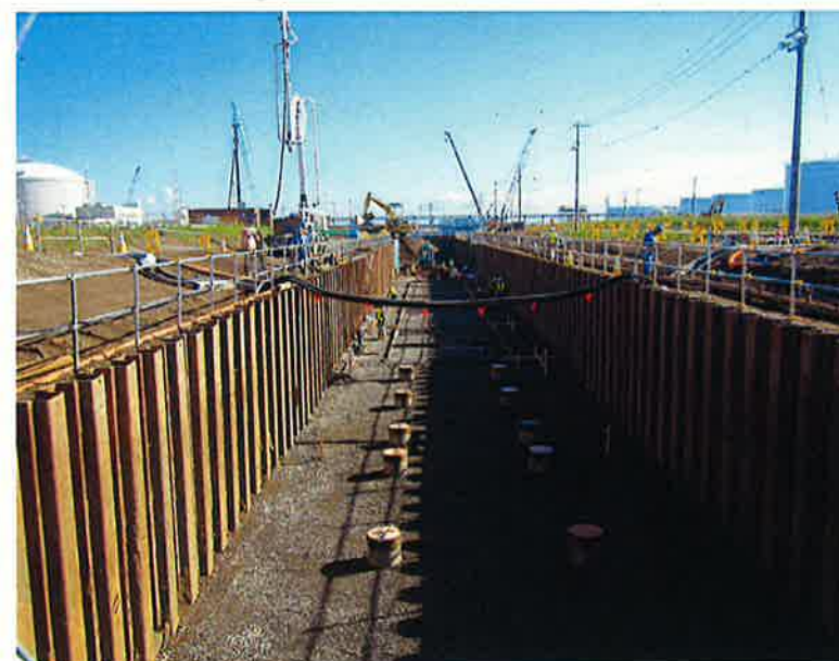
放水路 仮締切工状況（掘削）
