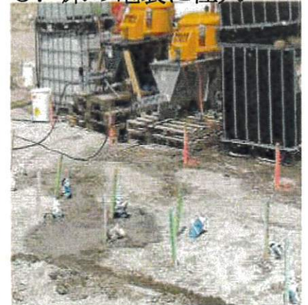
6. 地盤安定化注入
