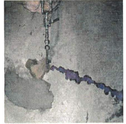
3. 床の亀裂に注入
