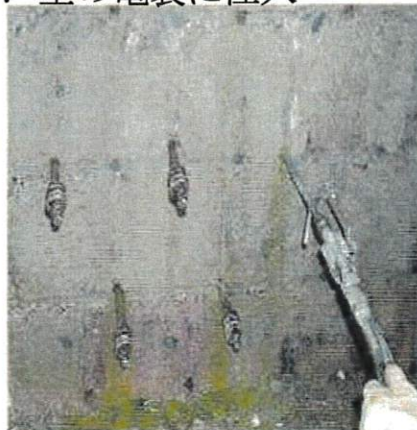
5. コンクリートへの注入
